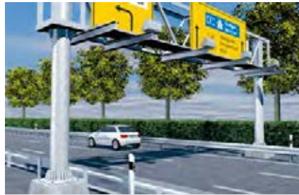
Estructuras para señalización vial
