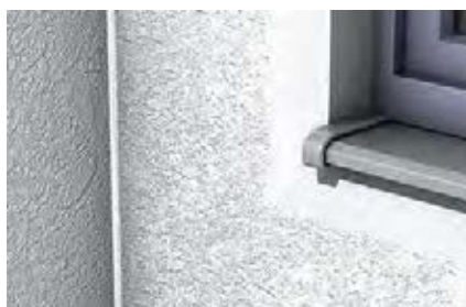
Juntas en paredes exteriores
