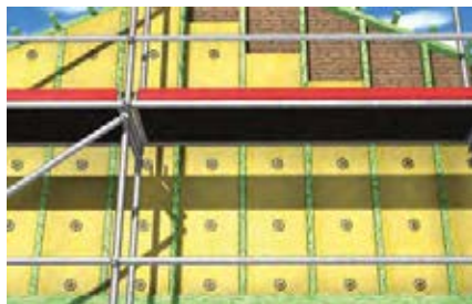
Materiales aislantes debajo de fachada ventilada
