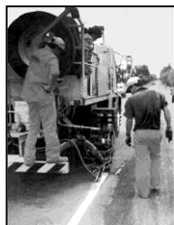
**TERMOVIAL S** en Blanco (**TERMOVIAL SB**) o Amarillo (**TERMOVIAL SA**), para demarcación de autopistas, carreteras, avenidas y calles de altos volúmenes de tránsito, de aplicación con equipos especiales, por proyección neumática, que ofrece gran durabilidad y gran visibilidad tanto diurna como nocturna.
