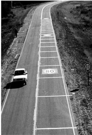
**TERMOVIAL X-HR** es una versión con máxima retro-reflexión residual (conteniendo mayor cantidad de microesferas incorporadas).
