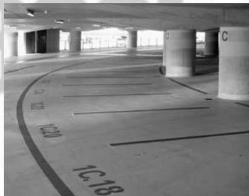
Cuando se deben marcar o revestir superficies cementicias, se recomienda la aplicación previa de nuestra **Imprimación Poliuretánica Transparente PRIMEX PU 72-216**. Tal aplicación, que rinde unos  $3 \text{ m}^2/\text{L}$ , deberá hacerse sobre superficies limpias y secas,  $4 \pm 1$  horas antes de la aplicación principal.
