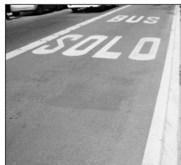
**LUMIFLEX PAF:** Material Plástico en Frío para Demarcación de Áreas. Es un Pavimento **Antideslizante de muy alta resistencia a la fricción y abrasión** tricomponente para el tratamiento de pavimentos donde se quiere lograr un muy buen “grip” como el caso de curvas, cruces de rutas donde aumenta la importancia de la superficie de frenado, etc.
