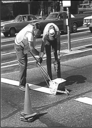
**TERMOVIAL X**, para demarcar autopistas, carreteras, avenidas y calles de altos volúmenes de tránsito, de aplicación por extrusión plana en 3 mm de espesor, y que ofrece la más alta durabilidad hasta ahora conseguida.
