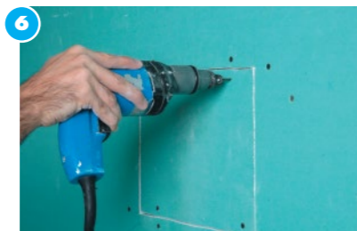
6 Cerramiento de la abertura Atornillar el recorte a los perfiles metálicos con tornillos punta aguja autoperforantes.
