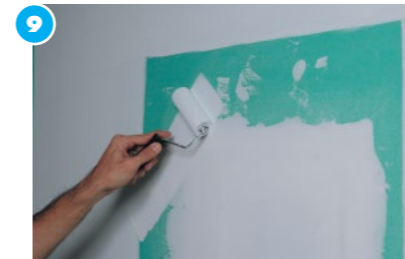
9 Terminación Para el correcto acabado, lijar, generar una imprimación con fijador y por último pintar.
