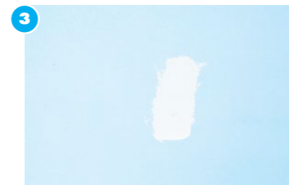
3 Terminación Una vez seca la masilla, prepare la superficie para la terminación: lijar, realizar una imprimación con fijador y por último pintar.
