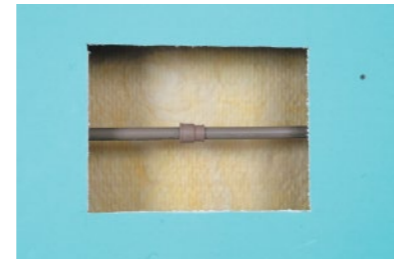
(caso de instalación sanitaria). Si el elemento aislante que se encuentra en el interior de la pared/revestimiento fue dañado, debe retirar y sustituir las partes dañadas o humedecidas.
