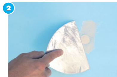
2 Preparación y masillado de la superficie Aplique con una espátula la masilla Uniflott Knauf hasta cubrir toda la perforación. Repita la operación hasta que la masilla, después de su tiempo de secado, no presente depresiones.
