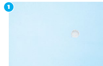
1 Daños en las placas de yeso Perforaciones de hasta 3 cm de diámetro pueden ser reparadas en hasta 3 etapas utilizando masilla Uniflott Knauf. Si supera este tamaño, se debe realizar una reparación con un recorte de placa.
