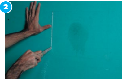
2 Corte de la placa de yeso Con un serrucho de punta, corte la placa del tamaño indicado.
