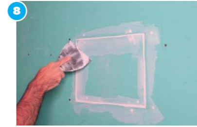
8 Masillado de las juntas Genere el tratamiento de juntas con la masilla Uniflott Knauf, la cual fue especialmente diseñada para el tratamiento sin cinta de papel. Aplique en primera medida en las juntas
